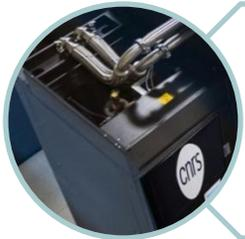
Refroidissement à eau tiède (Direct liquid Cooling –DLC- régime d'entrée à 30°C et de sortie à 40°C)
